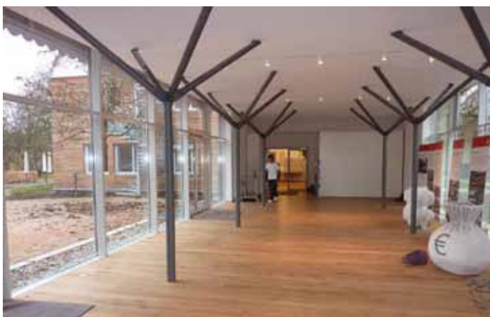
Baumartige Stützen im neuen Verbindungsgang
