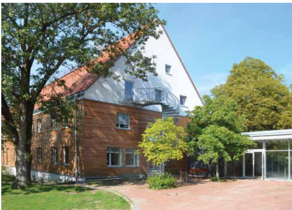
Saniertes Seminarhaus mit neuem Verbindungsgang
