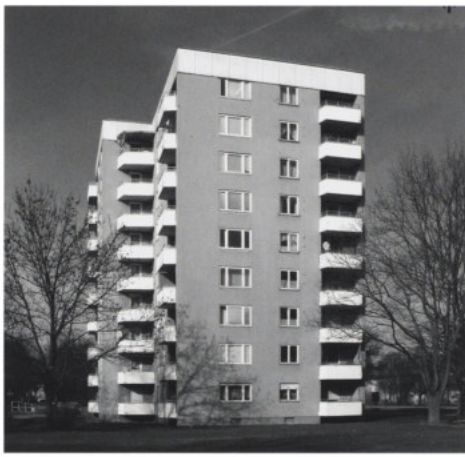
Vor der Modernisierung wirkten durchlaufende Balkonplatten als Kältebrücken. Heute sorgen verglaste Loggien für passive solare Energiegewinne.
