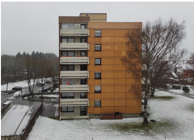
Bild 18: Bestandssituation Haus 7 b
