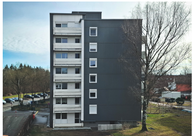
Bild 20: Sanierter Zustand Haus 7b
