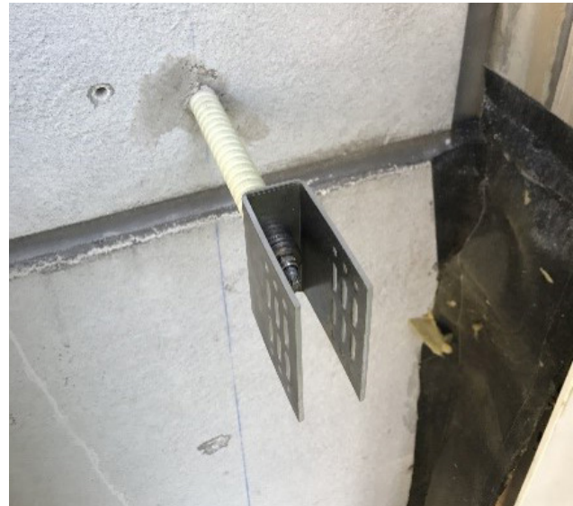
Bild 5: Einbau der Fassadenhalter
