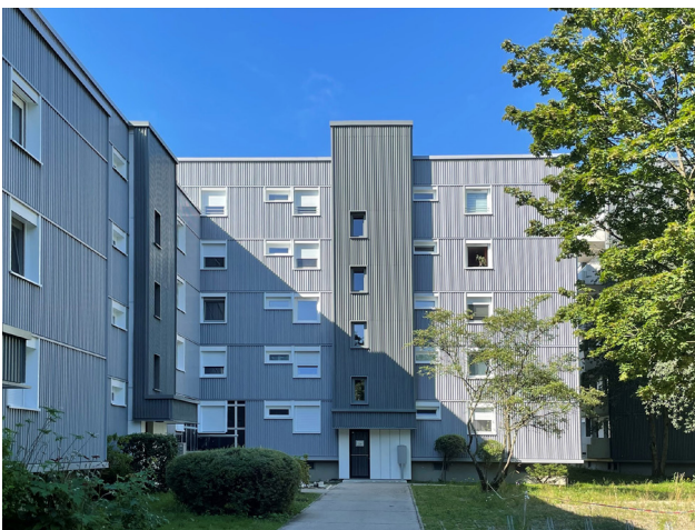
Bild 2: Eingangssituation von Haus 11a und 11b
